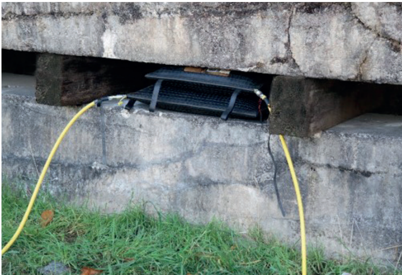
Abb. 47: Zwei Hebekissen übereinander
