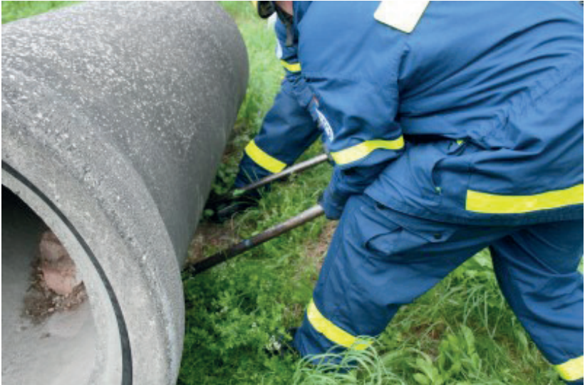
Abb. 25: Bewegen einer Betonröhre
