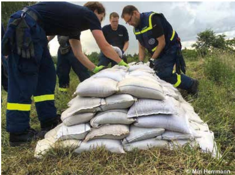
Abb. 55: Sandsackverlegung nach System
