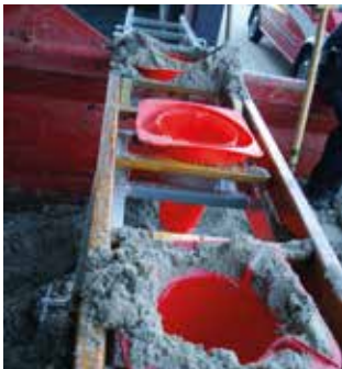
Abb. 45: Abgeschnittener Verkehrsleitkegel als Trichter
