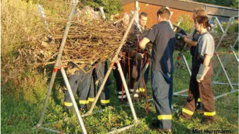
Abb. 63: Faschine – Aufbau
